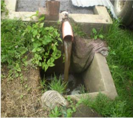
Foto 2. Agua residual generada por la máquina # 2, la cual es conducida por tubería hacia la palanta de tratamiento de aguas residuales.
