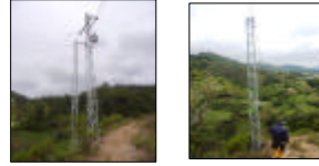
Fotos 13-14. Terrenos para soportar los cables para la ubicación de la nueva línea de interconexión eléctrica.
