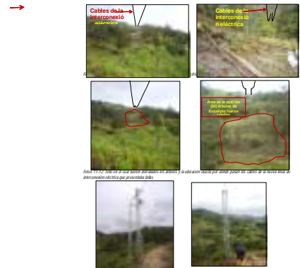
Fotos 9-14. Torres para soportar los cables para la ubicación de la nueva línea de alta tensión eléctrica.
