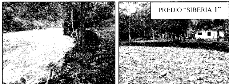
Fotografías Nos. 1 y 2. A la izquierda: extremo oeste del predio “Siberia 1” donde inicia afectación por socavación. A la derecha: Playón localizado al sur del predio “Siberia 1” que facilita que el cauce se recueste contra el terreno del predio en mención. Fuente: Autor 2021.
